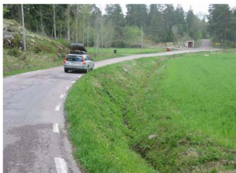
Bild 4a Ett parti med djupt dike och brant vägslänt. Här skulle man kunna rörlägga diket och flacka ut vägslänten med vägdikesmassor.
