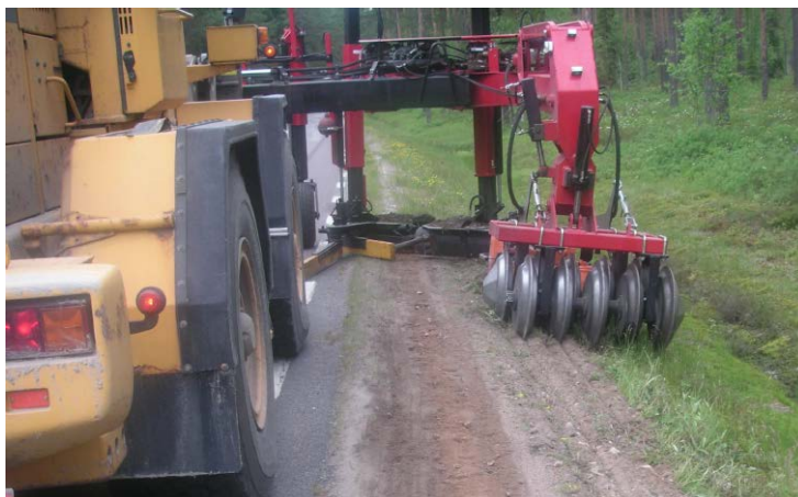
Bild 2, Kantskärning med väggkantsshyvel.
